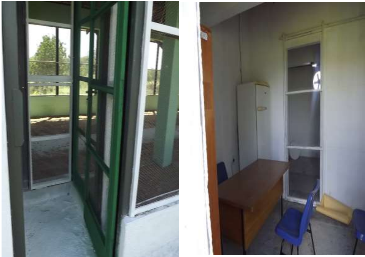
Figura 5 - Instalações de manutenção dos animais. A. Entrada do viveiro com pedilúvio e antessala telada. B – Escritório com refrigerador para amostras biológicas. C – Alojamento para repouso das aves, D – ambiente interno da sala de repouso
